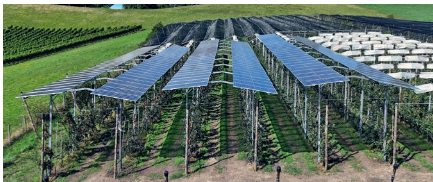
Unten Äpfel, oben 600 Quadratmeter Solarpanel: Forschungsanlage im Fricktal.
